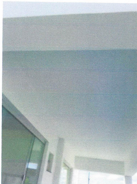
FOTO 6 – FORRO DE GESSO
